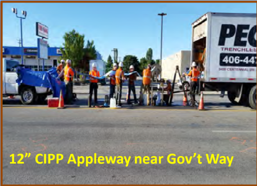
CIPP Trenchless Rehab
