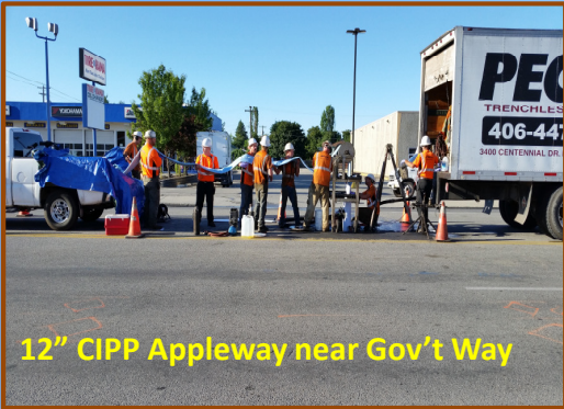
CIPP Trenchless Rehab
